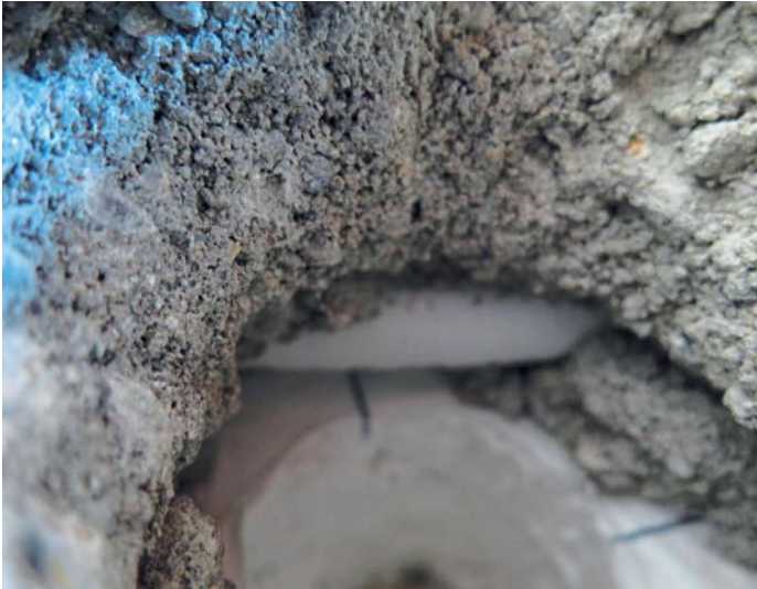
Bodenheizungsrohr ohne Verletzungen nach Spitzen von Hand.
