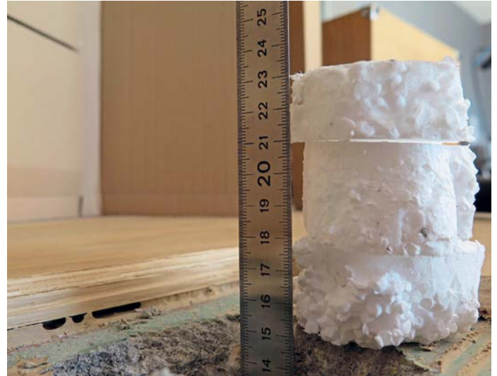
Gesamtstärke des Bodenaufbaus mit Zementmörtel und Dämmschichten.
