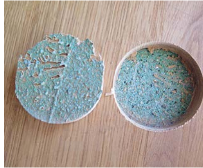
Grüne Beschichtung der Leimunterseite und Estrichoberfläche.
